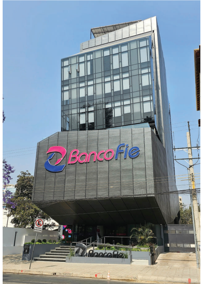
Cochabamba. Primer edificio sostenible de la Banca en Bolivia
